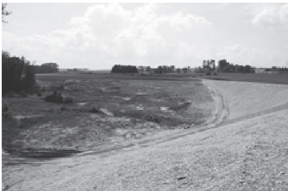
Durch das Rückhaltebecken in Rettenbrunn und das Rückhaltebecken Wötzing wird die Hochwassersituation im Unterlauf der Antiesen und seiner Zubringer wesentlich verbessert.
